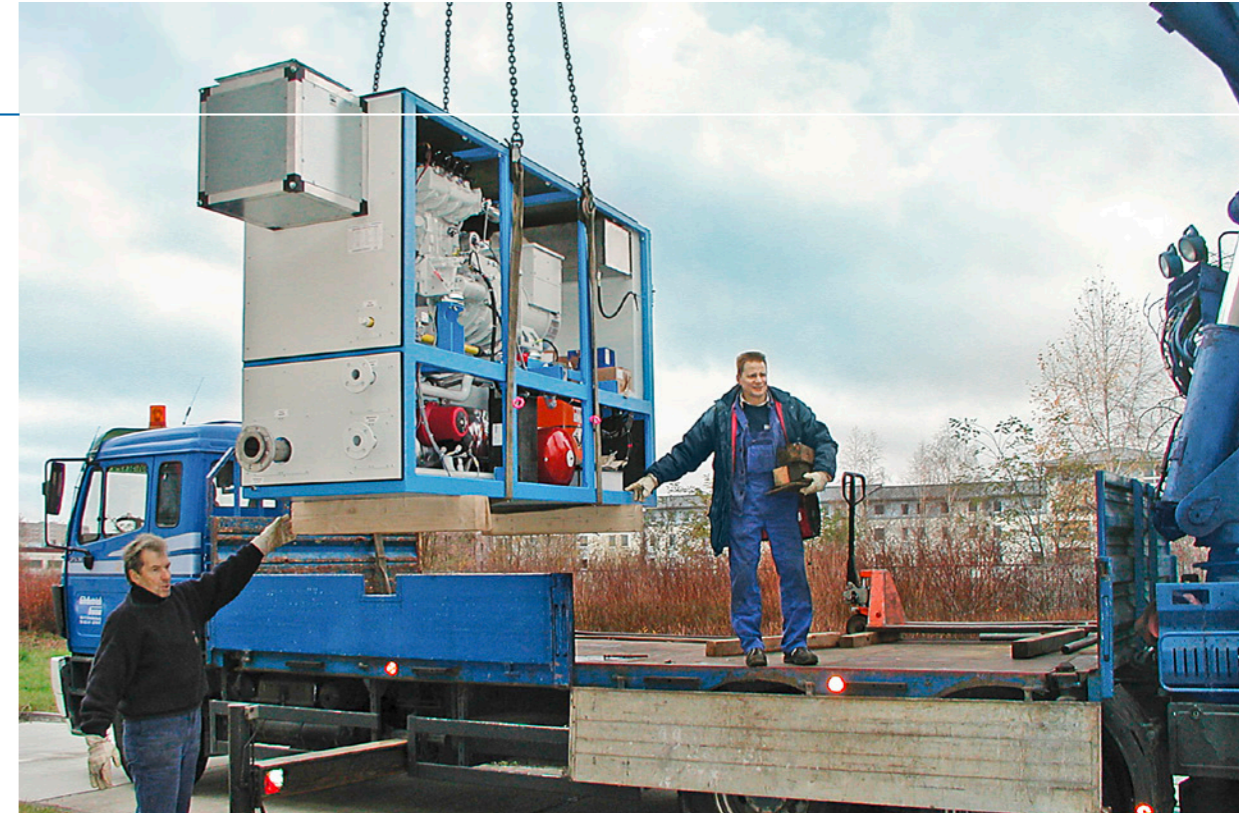
Anlieferung eines modernen Blockheizkraftwerks für das Heizwerk in Altglienicke
