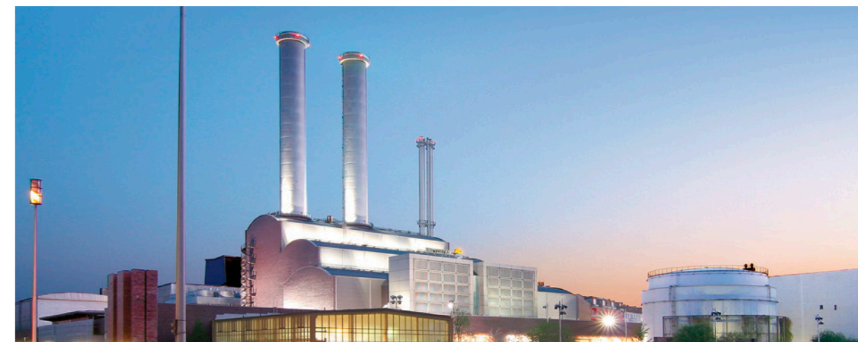
Das Heizkraftwerk Mitte gehört zu den modernsten Kraft-Wärme-Kopplungsanlagen der Welt
