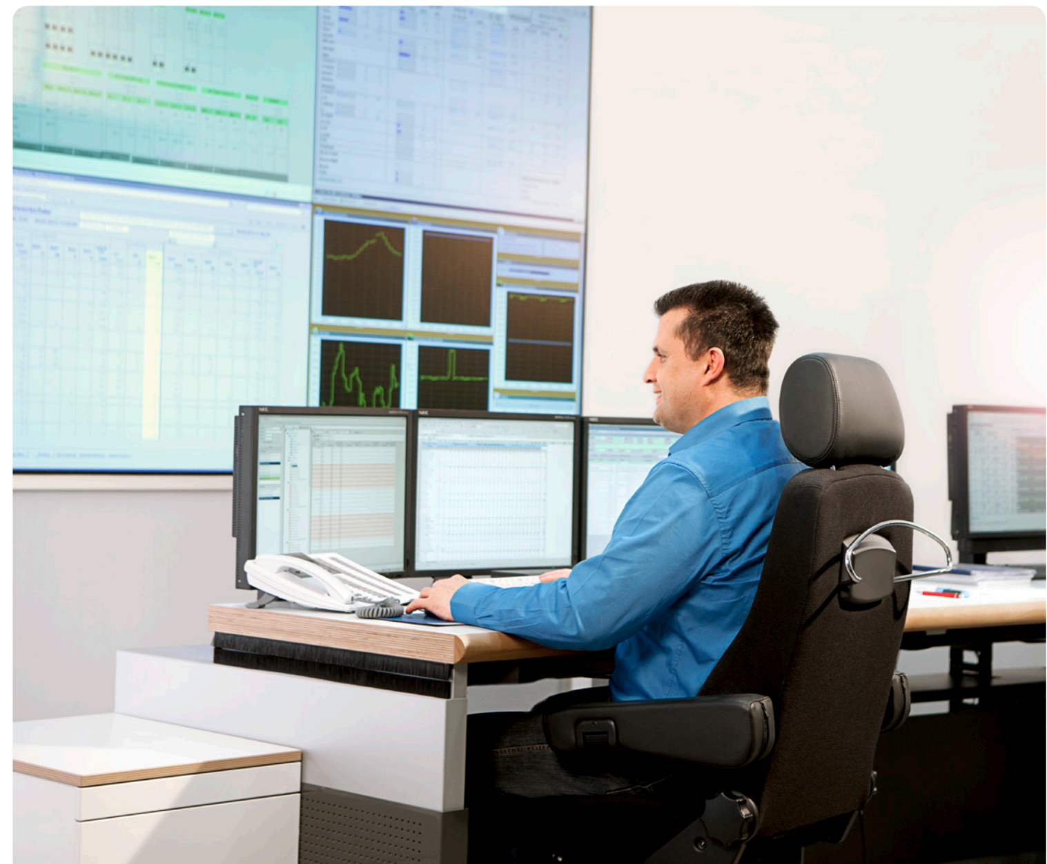
Schaltzentrale des Virtuellen Kraftwerks in Berlin – alles im Blick und alles im Griff.
