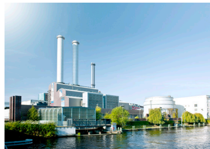
Das Heizkraftwerk Mitte – innovativ, sauber, effizient.
